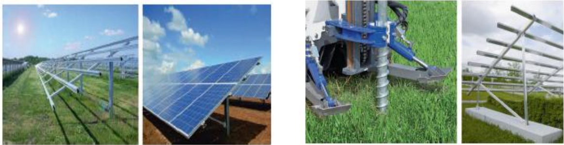
Fig. 2.79 Mënyra të ndryshme të fiksimit të paneleve (Krinner Schraubfundamente GmbH)
